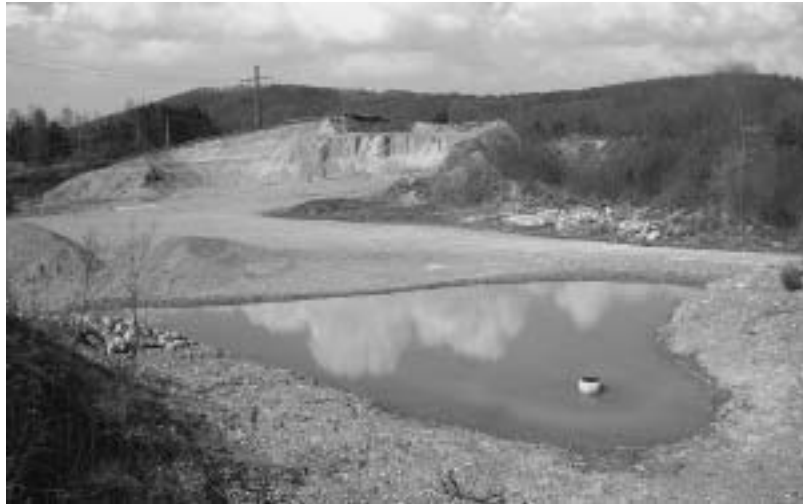
Abb. 2: Ablassbarer Tümpel mit sichtbarem Entwässerungsschacht. Auch hier wird das Wasser in eine Sickergrube geleitet.
