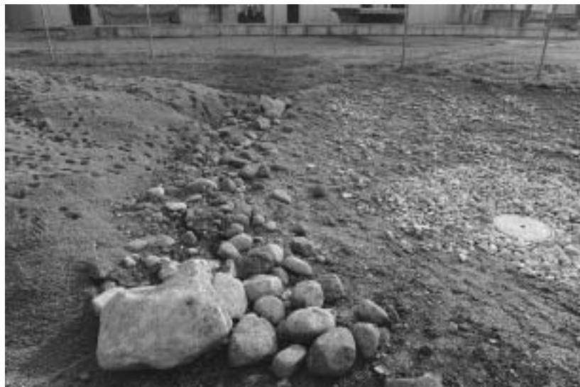
Abb. 4: Stellenweise wurde auf der Gewässersole Geröll (30/60 mm) als Versteckstruktur für die Larven ausgebracht. Am Ufer wurden Steinstrukturen als Versteck für aussteigende Jungkröten eingebaut. Eine Sandhalde findet sich direkt anschließend.
